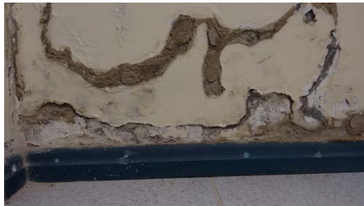
descolamento por empolamento
