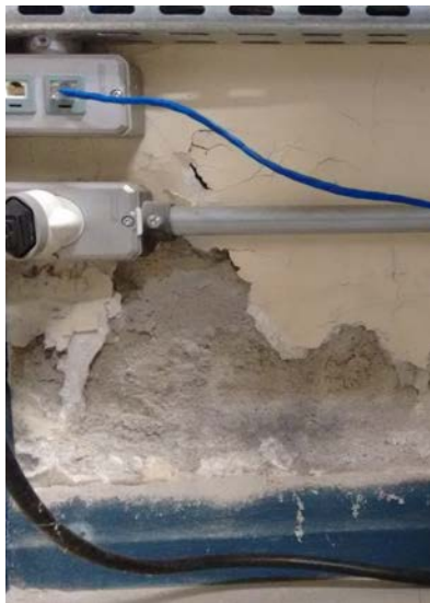
descolamento por empolamento
